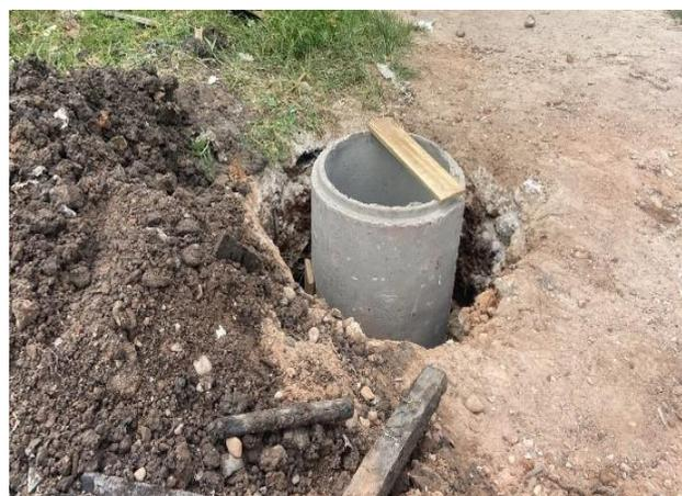
**FOTO 64:** EXECUÇÃO DE DRENAGEM AUXILIAR
