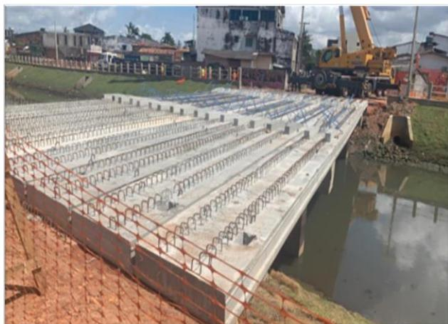
**FOTO 47: SERVIÇO DE CONCRETAGEM DE PONTE**
