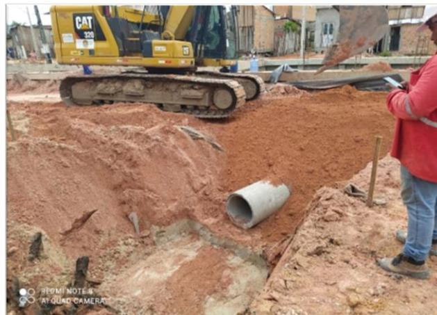
**FOTO 58: SERVIÇO DE REDE DE DRENAGEM PLUVIAL**
