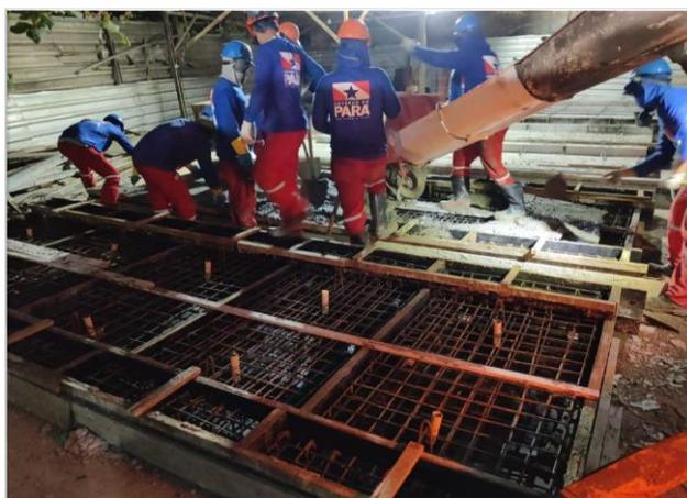
**FOTO 54 MOLDAGEM DAS PLACAS PARA OS CANAIS**
