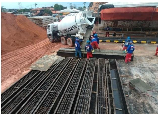
**FOTO 53: MOLDAGEM DAS ESTACAS PARA OS CANAIS**
