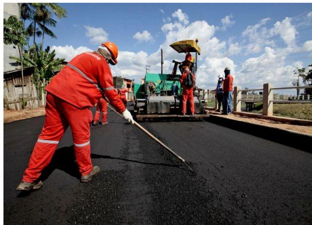
**FOTO 49: SERVIÇO DE PAVIMENTAÇÃO ASFÁLTICA**
