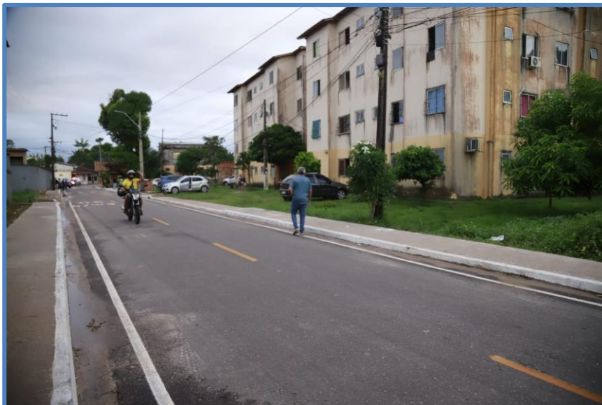
FOTO 04: Município de Belém: Pavimentação asfáltica, drenagem profunda, calçada, meio-fio, sarjeta e sinalização no Bairro Coqueiro.
