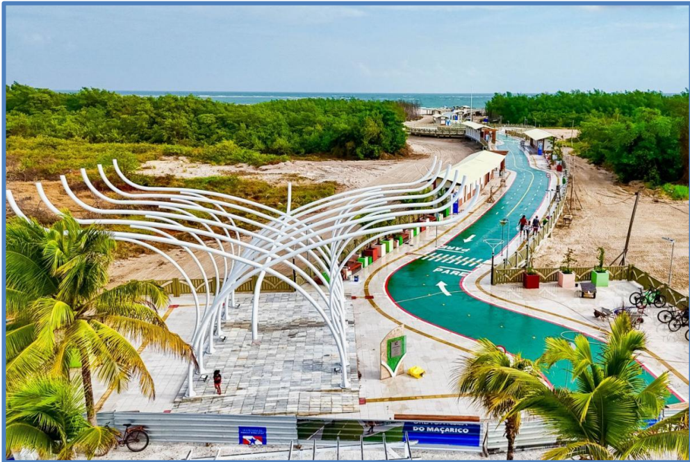
FOTO 19: Município de Salinópolis: Nova Passarela Urbana da Praia do Maçarico.
