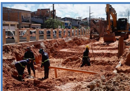
FOTO 55: Início das obras de macrodrenagem.
