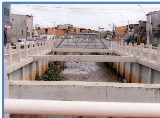
FOTO 44: Reconstrução das paredes do canal.
