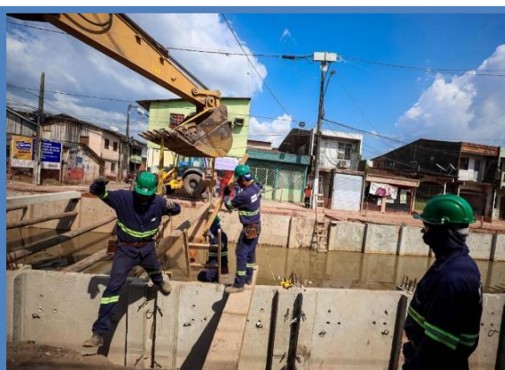
FOTO 43: Finalização da estrutura de concreto.
