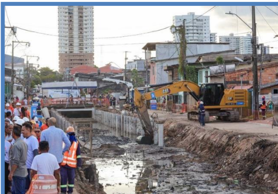
FOTO 41: Serviço de limpeza com utilização do maquinário.
