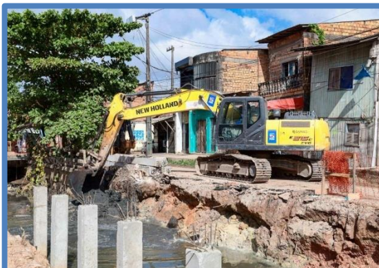
FOTO 51: Serviço de cravação de estacas flutuantes.
