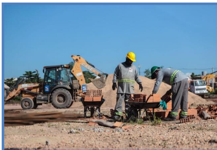
FOTO 59: Serviço da troca de solo.
