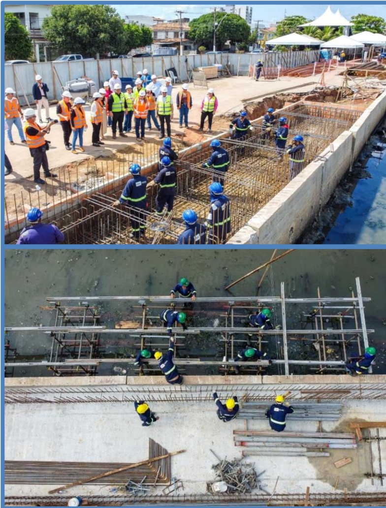
FOTO 40: Construção das estruturas das passarelas do Parque Linear.
