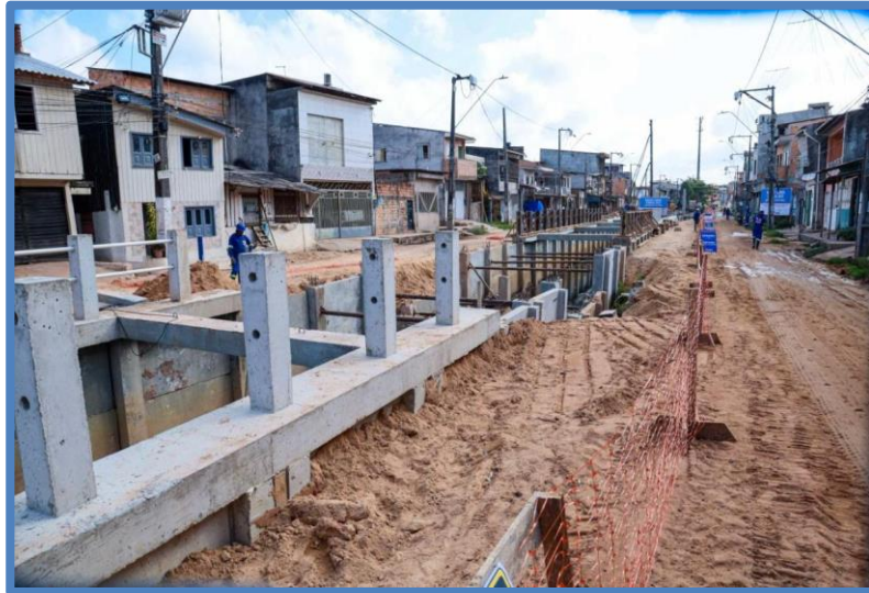
FOTO 53: Preparação para instalação das passarelas.
