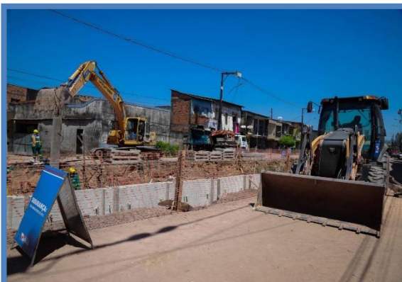
FOTO 45: Serviço de terraplenagem com utilização do maquinário.
