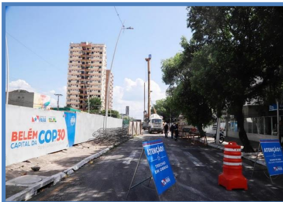
FOTO 37: Tráfego parcialmente interditado na Av. Almirante Tamandaré.
