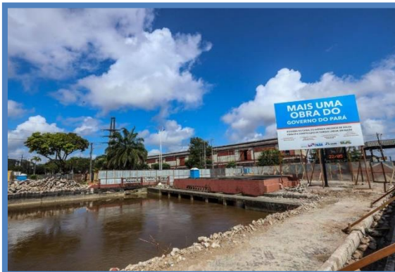
FOTO 28: Interdição do perímetro entre as Ruas Belém e Municipalidade para retirada da mureta de proteção do canal e das pedras da pista de passeio.
