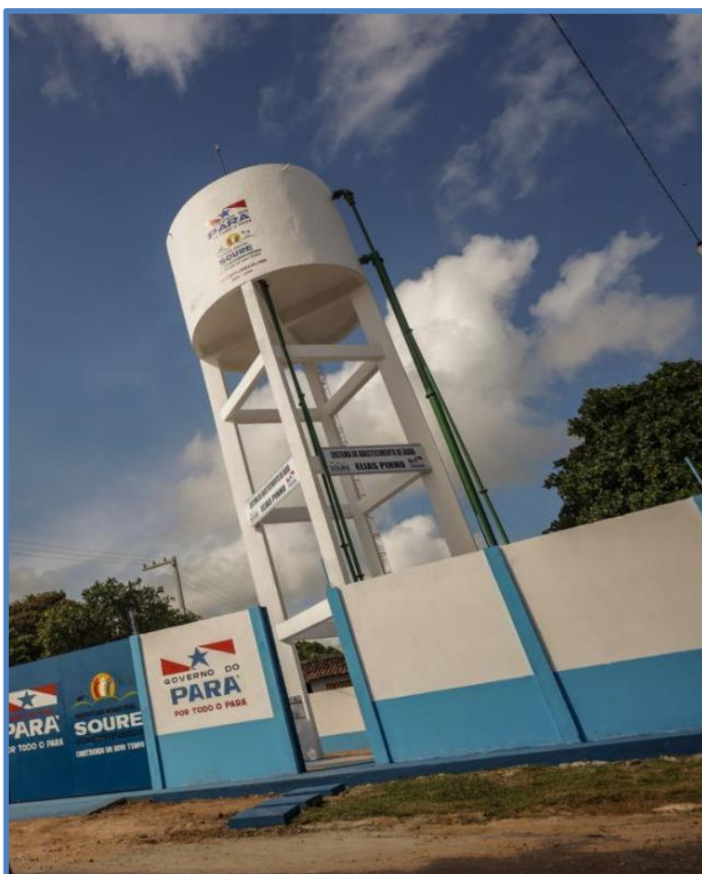
FOTO 03: Município de Soure: Sistema de Abastecimento da 4ª Rua
