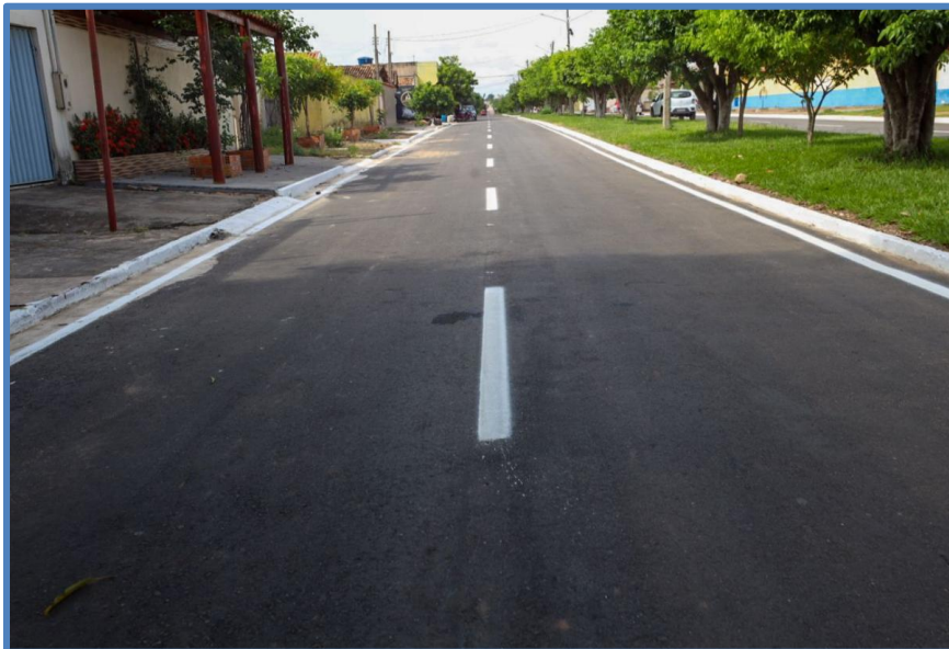
FOTO 13: Município de Rio Maria: Terraplanagem, pavimentação asfáltica, drenagem, calçada, meio-fio, sarjeta e sinalização.
