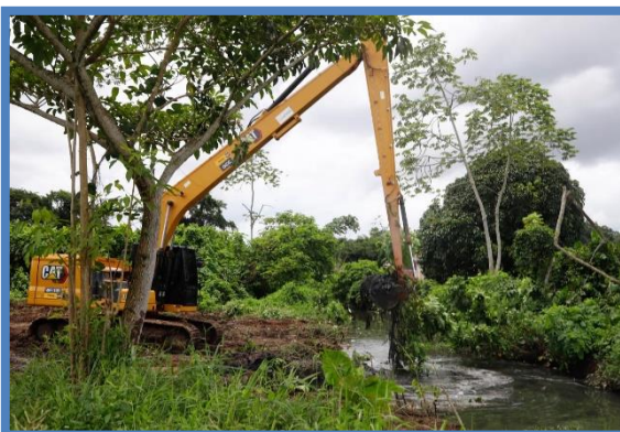
FOTO 24: Serviços de Limpeza com utilização de maquinário.
