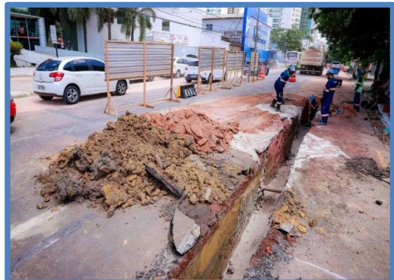
FOTO 34: Início das obras de saneamento ambiental.
