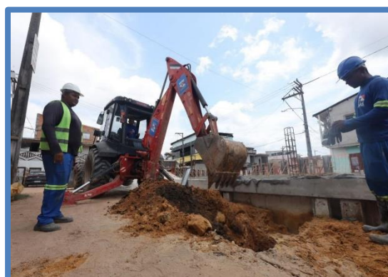
FOTO 56: Serviço de escavação e retificação do canal.
