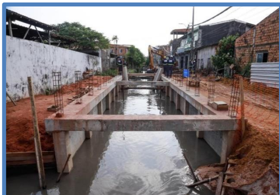
FOTO 27: Retificação do canal em parede de concreto.
