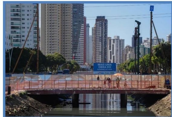
FOTO 29: Cravação de estacas metálicas de sustentação da estrutura do canal.
