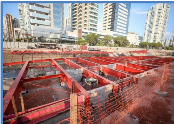
FOTO 33: Instalação das vigas metálicas e concretagem das estruturas que sustentarão o parque linear.
