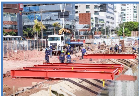
FOTO 31: Recebimento das estruturas metálicas.
