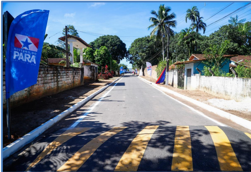
FOTO 10: Município de Benevides: Pavimentação asfáltica, drenagem profunda e superficial, calçada, meio-fio, sarjeta e sinalização no Bairro Campestre.
