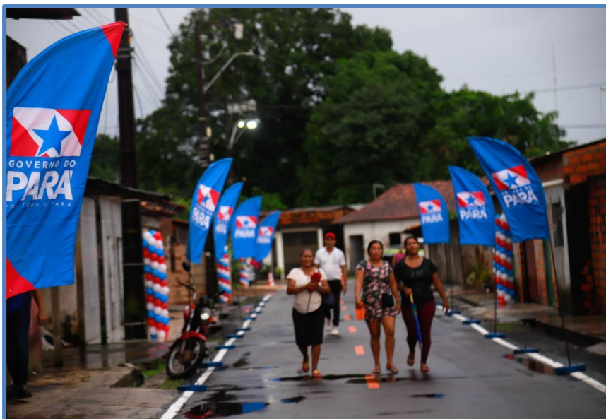
FOTO 08: Município de Marituba: Pavimentação asfáltica, drenagem, calçada, meio-fio, sarjeta e sinalização na Comunidade Japão.
