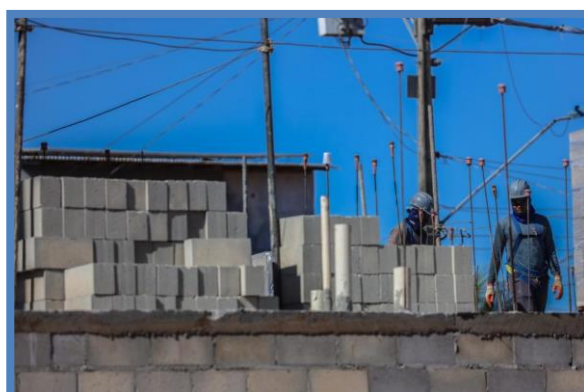
FOTO 61: Serviço estrutural nos blocos residenciais.
