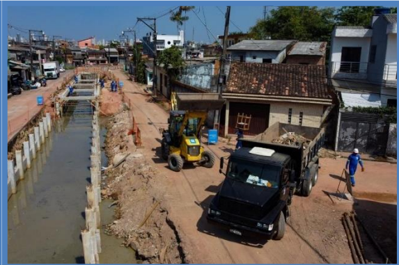
FOTO 50: Serviços de cravação de estacas flutuantes, instalação das placas de contenção e estroncas superiores, vigas de coroamento e pilaretes que servirão como guarda corpo.
