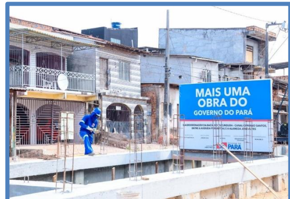
FOTO 52: Serviços de reconstrução das paredes do canal e instalação das placas de contenção.
