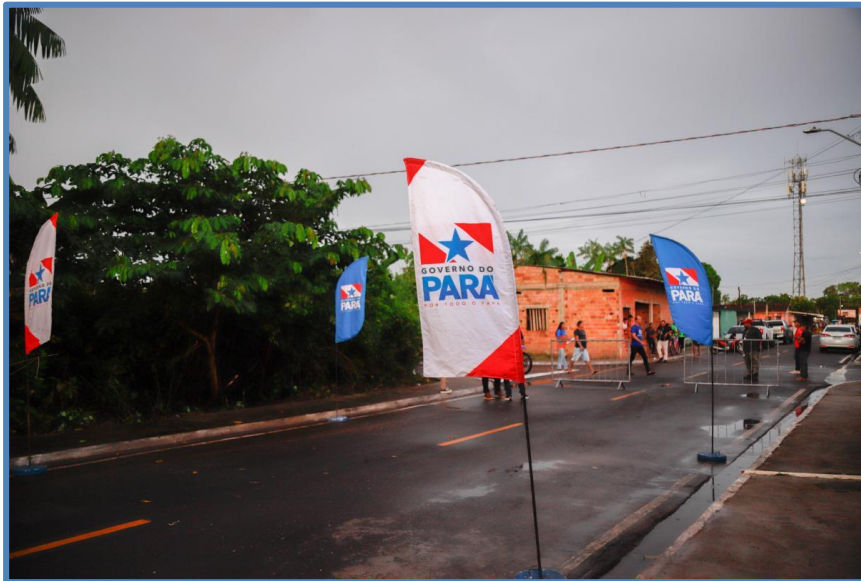
FOTO 06: Município de Belém: Terraplenagem, pavimentação asfáltica, drenagem, calçada, meio-fio, sarjeta e sinalização no Distrito de Outeiro.
