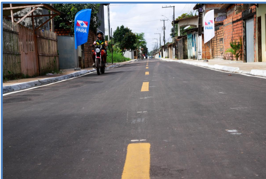
FOTO 07: Município de Belém: Terraplenagem, pavimentação asfáltica, drenagem profunda, calçada, meio-fio, sarjeta e sinalização no Bairro Tapanã.
