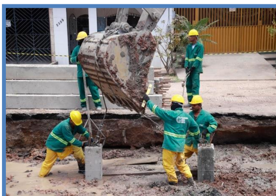
FOTO 48: Serviço de cravação de estacas e remoção do solo.
