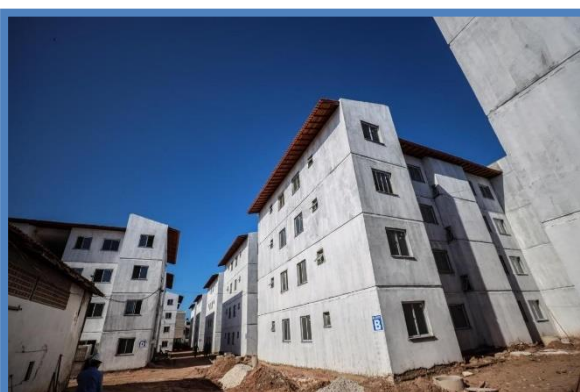
FOTO 60: Serviço de acabamento dos blocos residenciais.
