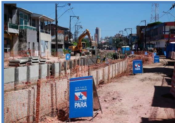
FOTO 46: Serviço de revestimento do canal com placas de concreto.
