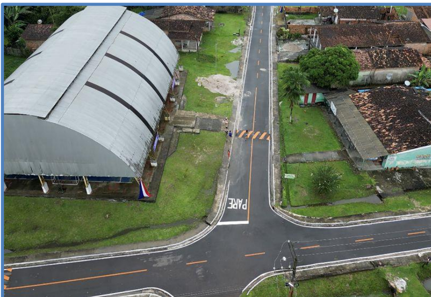
FOTO 09: Município de Santa Bárbara: Pavimentação asfáltica, drenagem, calçada, meio-fio, sarjeta e sinalização na Comunidade de Genipaúba.
