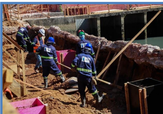
FOTO 30: Reaterro de fundação.
