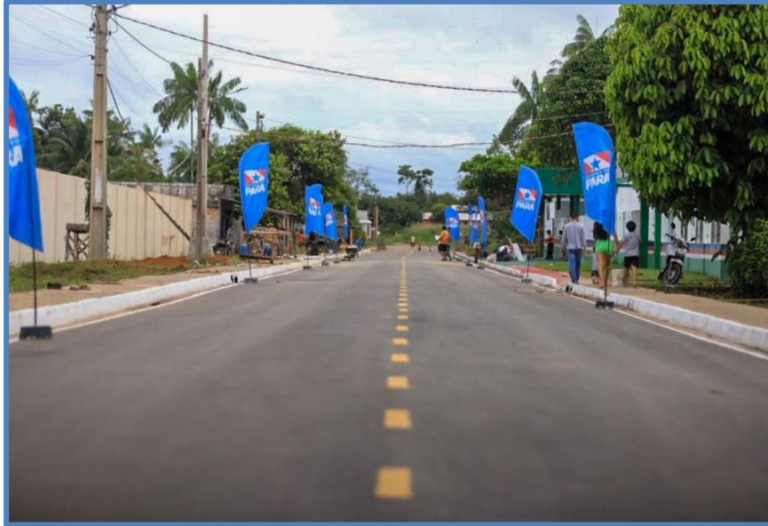
FOTO 12: Município de Porto de Moz: Terraplanagem, pavimentação asfáltica, drenagem, calçada, meio-fio, sarjeta e sinalização.
