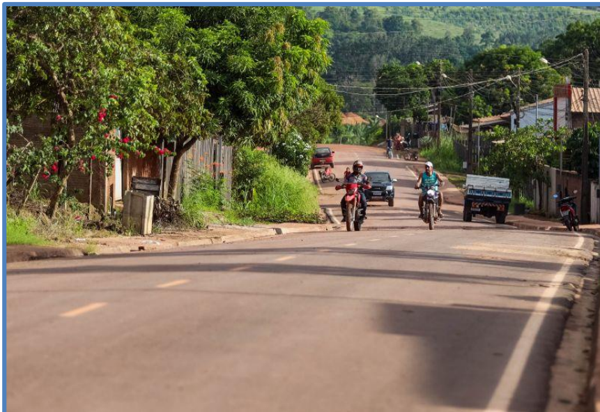
FOTO 11: Município de Rurópolis: Terraplanagem, pavimentação asfáltica, drenagem profunda e superficial, calçada, meio-fio, sarjeta e sinalização.
