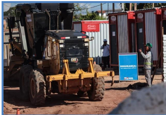
FOTO 58: Serviço de terraplenagem no sistema viário.
