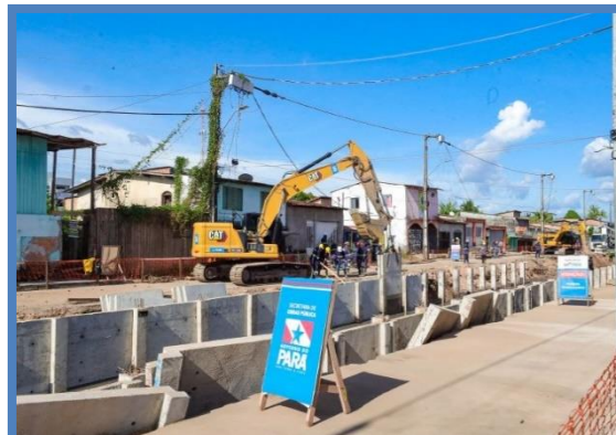
FOTO 42: Serviço de revestimento do canal com placas de concreto.
