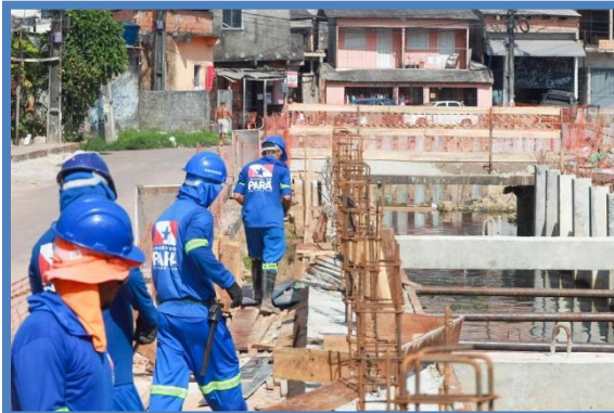
FOTO 50: Serviços de cravação de estacas flutuantes, instalação das placas de contenção e estroncas superiores, vigas de coroamento e pilaretes que servirão como guarda corpo.
