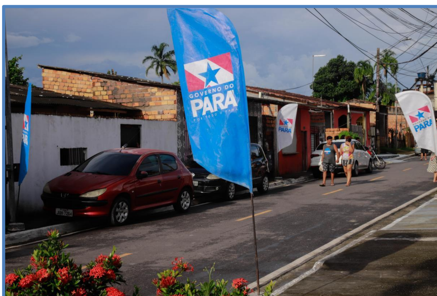
FOTO 05: Município de Belém: Terraplenagem, pavimentação asfáltica, drenagem, calçada, meio-fio, sarjeta e sinalização na Bairro Sideral.
