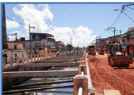
FOTO 47: Serviço de reestruturação com utilização do maquinário.
