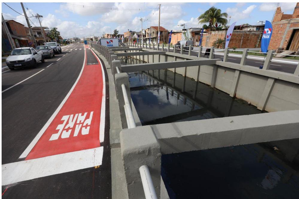
FOTO 03 – Reconstrução do canal em placas de concreto armado.
