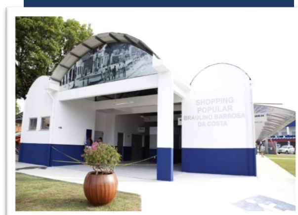
Foto 28: Construção do Shopping Popular Município de Capanema
