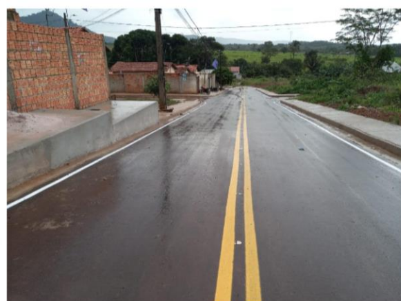
Foto 19: Drenagem e Pavimentação Município de Curionópolis
