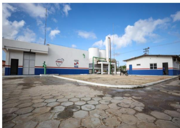
Foto 16: Sistema de Abastecimento de Água Município de Ourém
