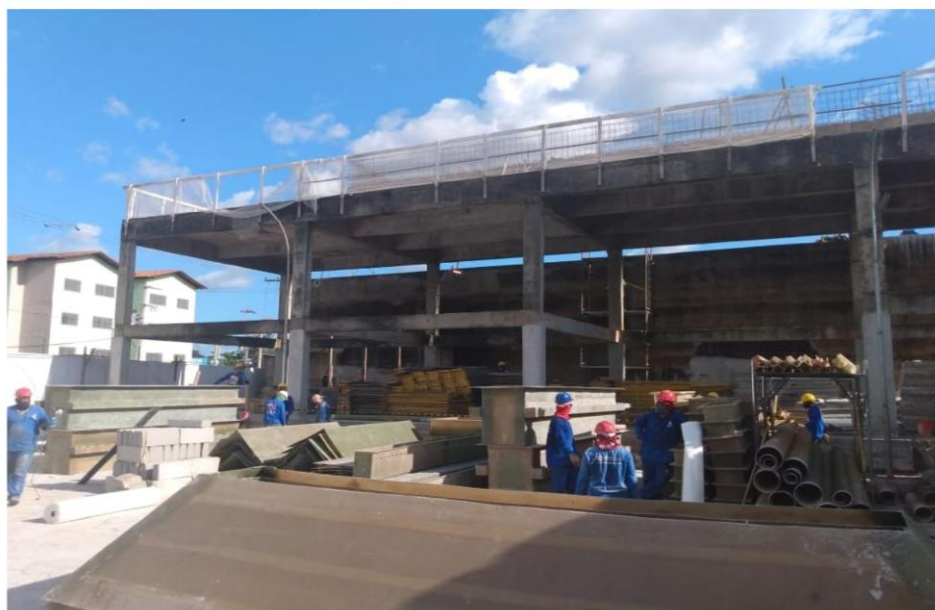
Foto 32: Estação de Tratamento de Esgoto em fase de conclusão.
