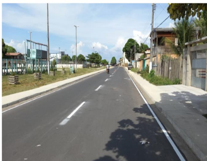
Foto 08: Pavimentação e Drenagem de vias Município de Portel
