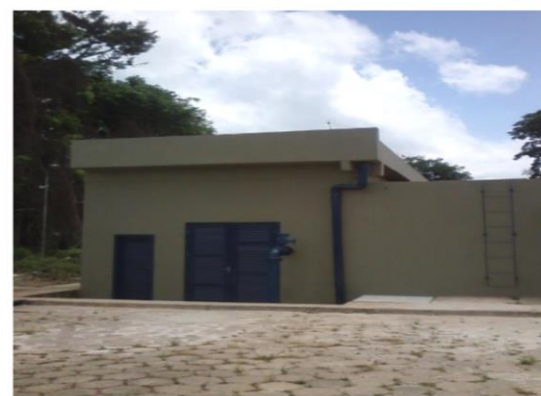
Foto 04: Casa de Bomba Município de São Caetano de Odivelas
