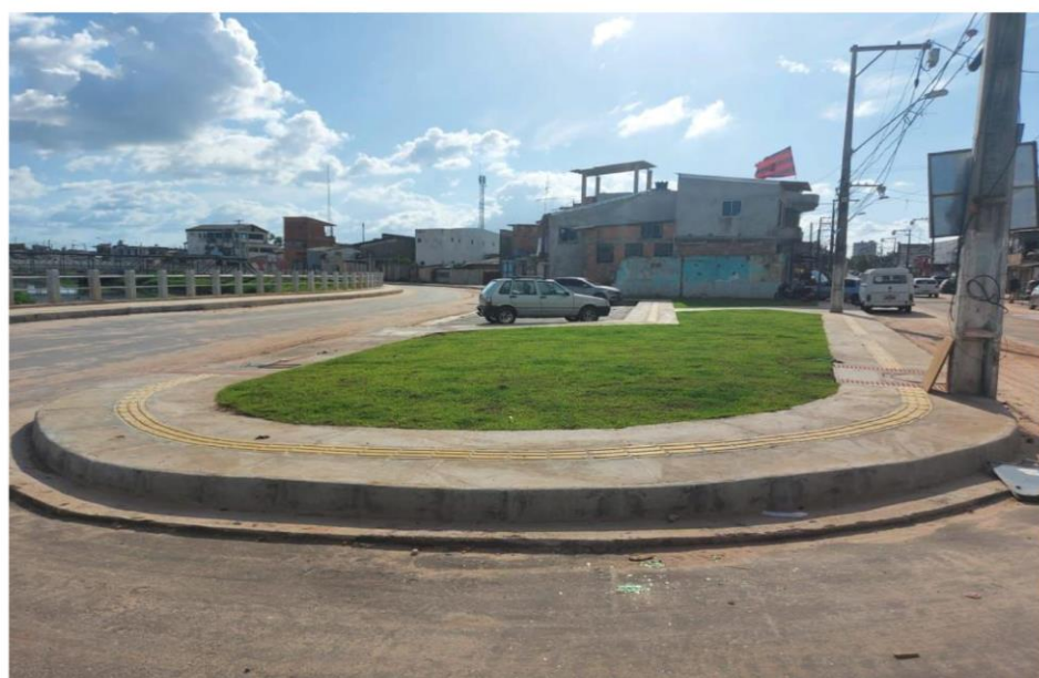
Foto 36: Execução da parte urbanística.
