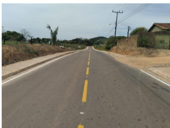
Foto 18: Drenagem e Pavimentação Município de Bannach
