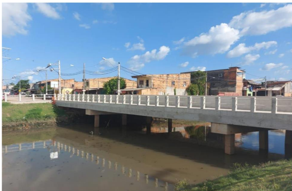
Foto 35: Conclusão da Ponte da Passagem Orquídea.
