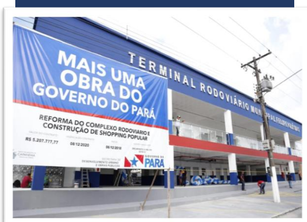
Foto 27: Reforma do Complexo Rodoviário Município de Capanema
