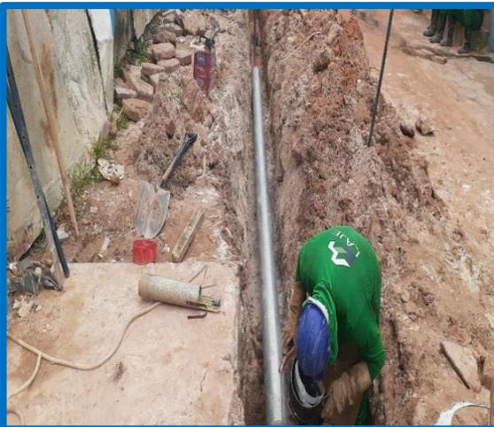
**FOTO 05:** REDE DE PROTEÇÃO E COMBATE A INCÊNDIO
