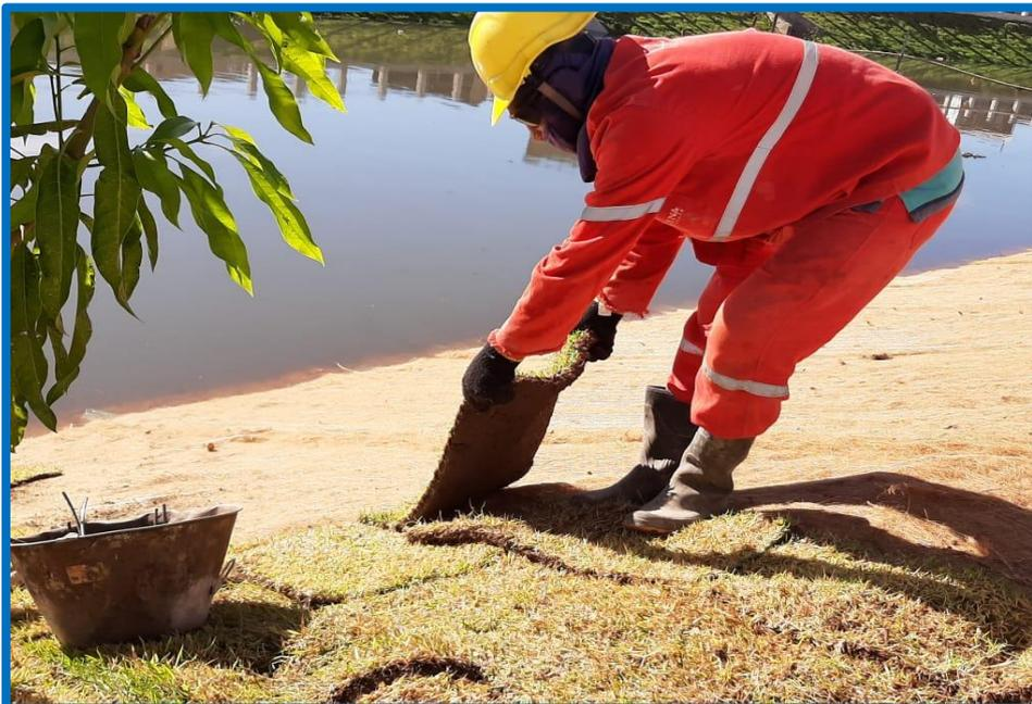
**FOTO 02: REVESTIMENTO EM GRAMA NO TALUDE**
