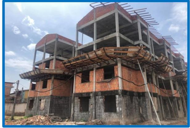
**FOTO 02:** EXECUÇÃO DE PILARES, VIGAS E LAJES
