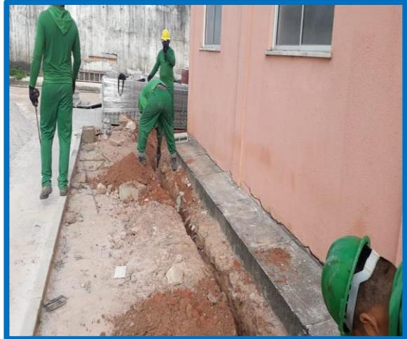
**FOTO 02:** EXECUÇÃO DO SISTEMA DE PROTEÇÃO DE DESCARGA ATMOSFÉRICA - SPDA
