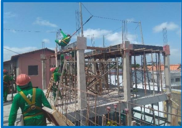
**FOTO 01:** MONTAGEM DE FORMAS DE PILARES, VIGAS E LAJES
